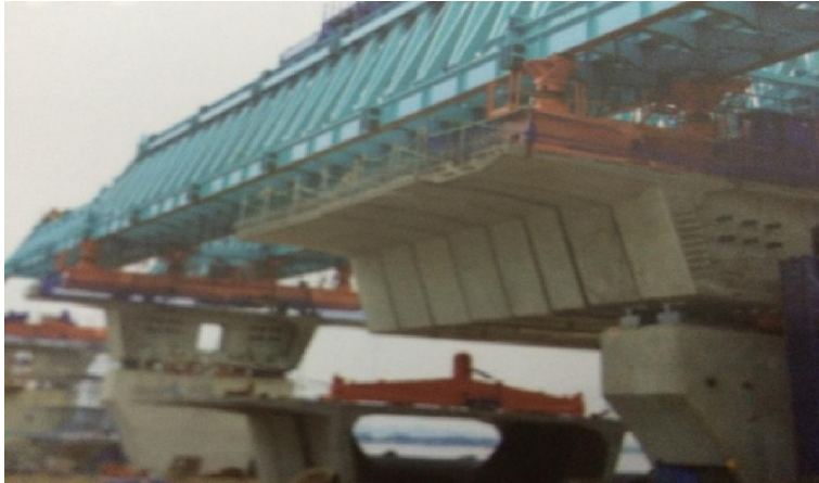
Hình 6. Các đốt dầm được câu lên.
