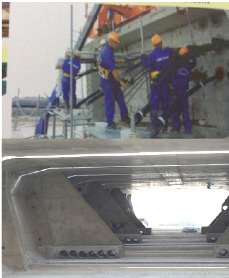
Hình 7. Tạo ứng suất trước.
