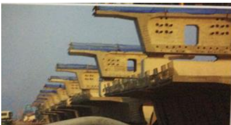
Hình 5. Đặt các đốt dầm lên đỉnh trụ cầu
